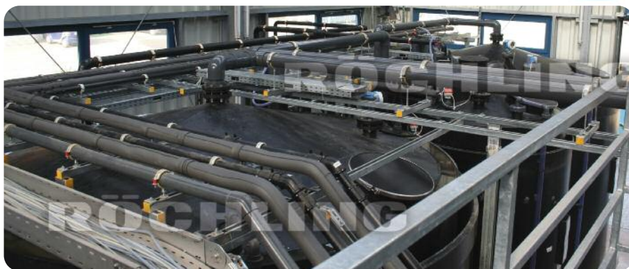
Polystone® G black B 100 Prozessbehälter für die Abwasserbehandlung Process tanks for waste water treatment
