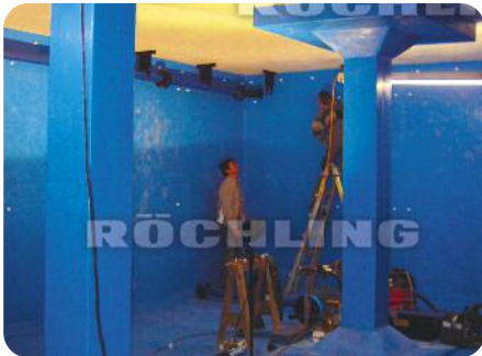
Auskleidung eines Speicherbeckens für Trinkwasser Lining of a storage tank for drinking water
